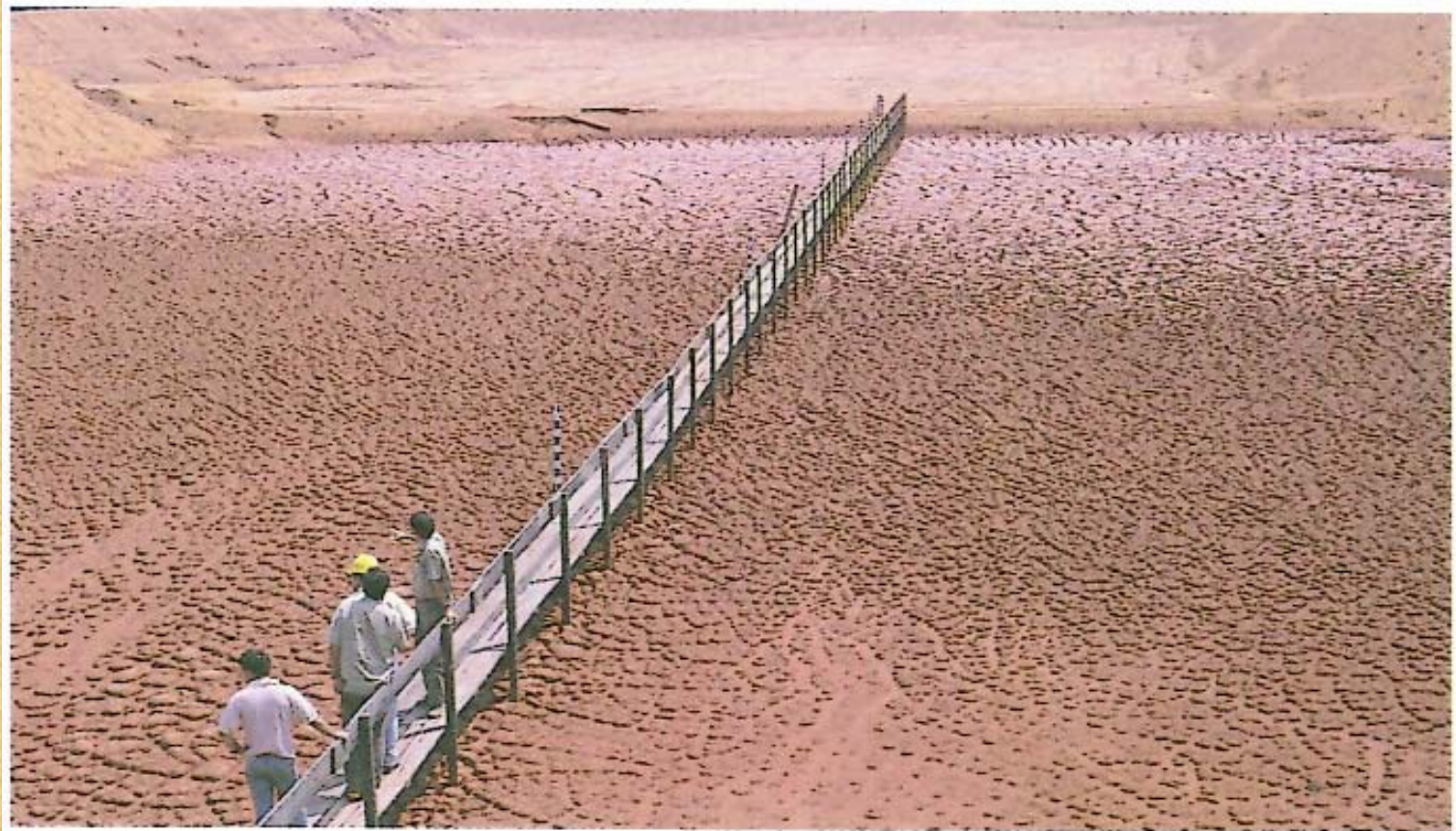
Foto 1. Tanque de depósito de rejeito da lavagem de bauxita, em Porto Trombetas-PA.
