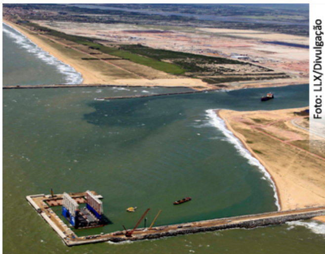
Construção do canal e terminal onshore do Superporto do Açu - TX2
